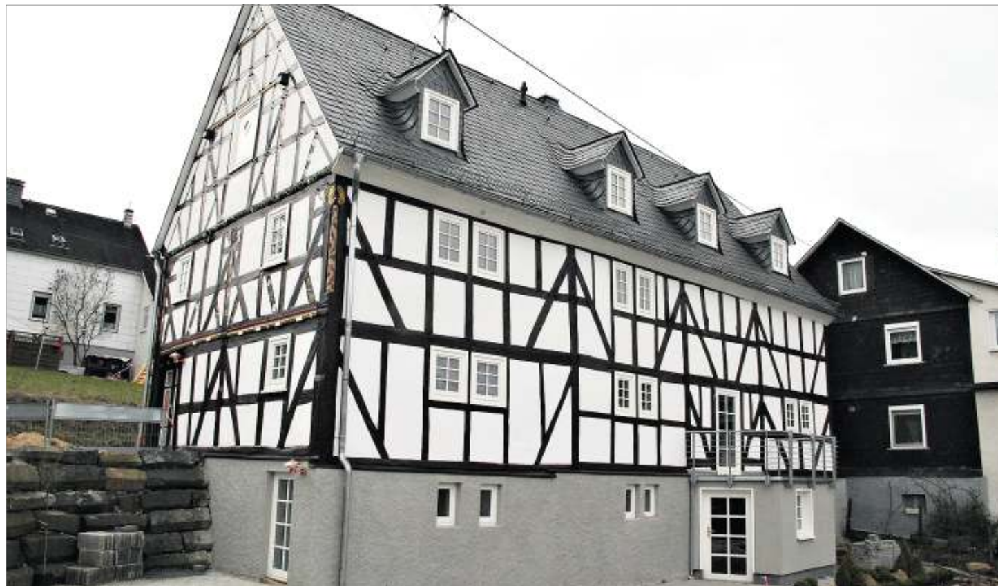
Seit über 200 Jahren steht das Haus Toni Weber in Altenseelbach. In einem solch guten Zustand wie jetzt dürfte sich das alte Gemäuer jedoch selten befunden haben. Foto: jak
